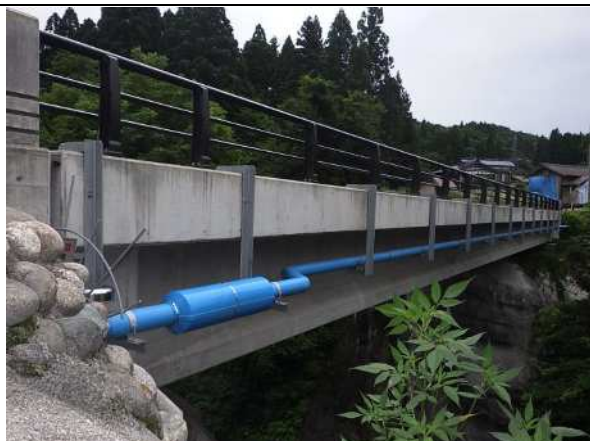
写真全景（協栄橋（コンクリート橋））
