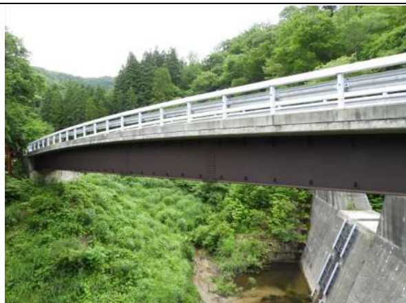
写真全景（石神沢橋（鋼橋））
